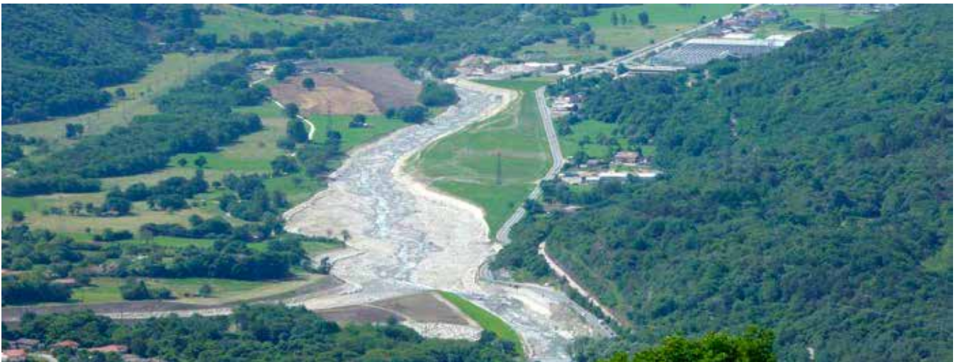
Sonico: opere di regimazione e contenimento alla confluenza del torrente Rabbia con il fiume Oglio (2018).
